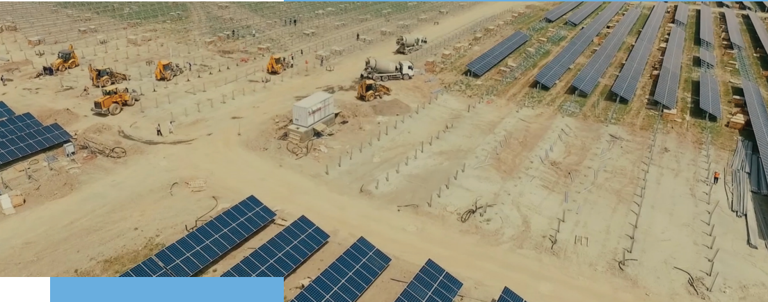
Panel surya sedang dipasang di Kazakhstan Selatan (foto dari Baikonyr Solar Limited Liability Company).
